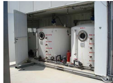
PLANTA DE BIOGÁS
