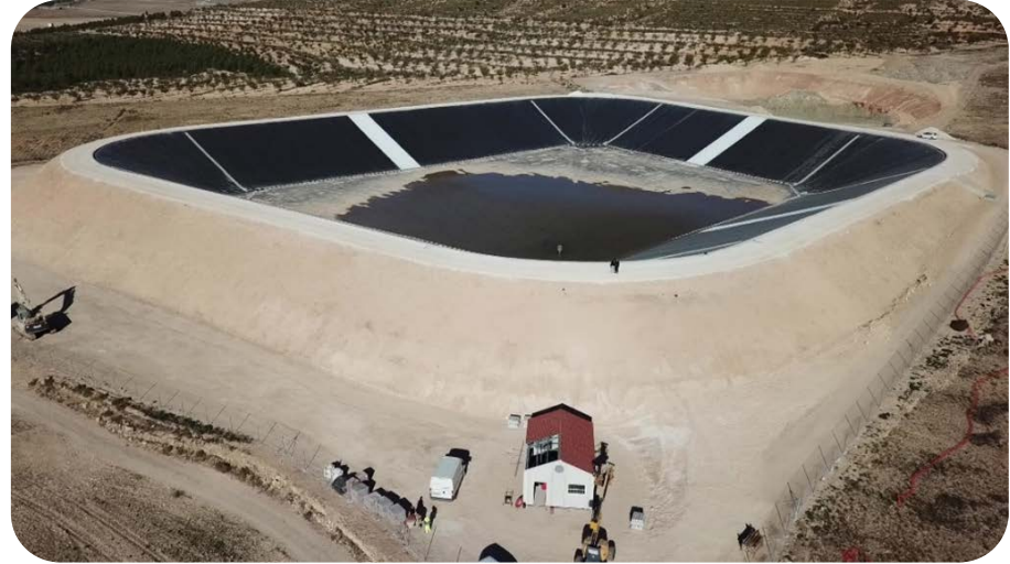
Balsa de regulación (vista panorámica)
